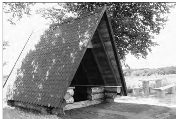
Neue Wanderhütte beim Napoleonweg (Sallmannshäuser Rennsteig) in der Gemarkung Unterellen
